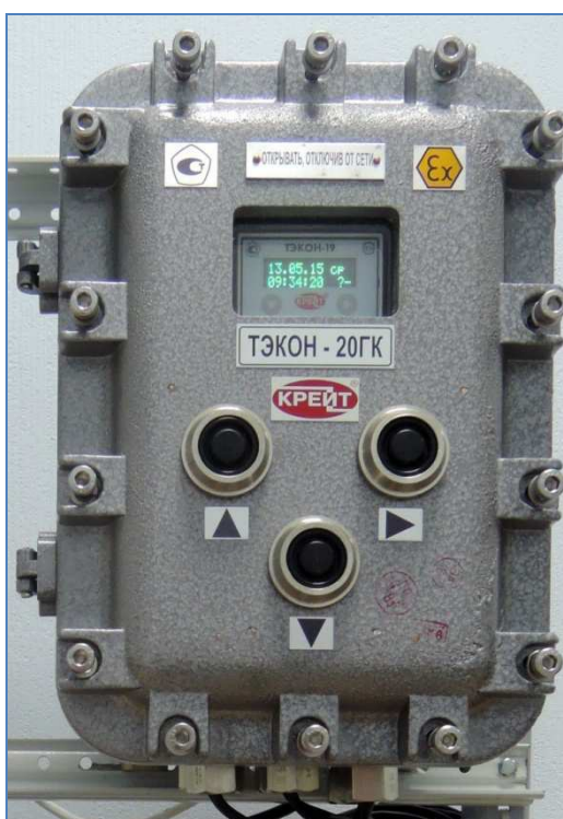
Рисунок 7. Передняя панель корректора расхода газа ТЭКОН-19ГК
